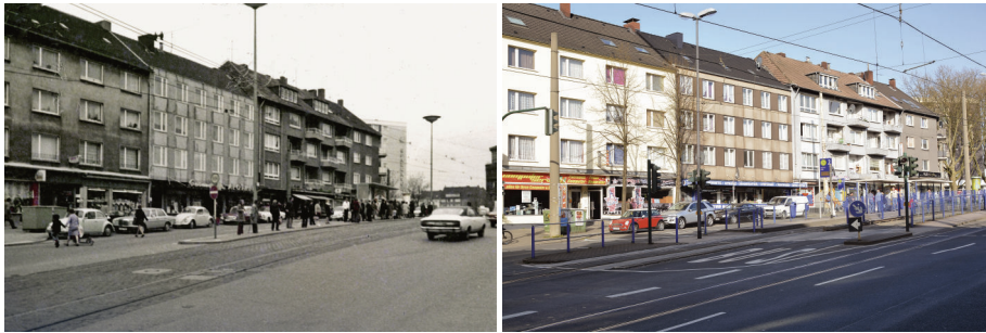
Abbildung 3.16: E · SO · 03 Steeler Straße. Die Straße hat ihre Funktion als wichtige Ausfallstraße mit Straßenbahn vom Zentrum nach Südosten behalten, wurde inzwischen aber neu gestaltet und dabei der ÖPNV-Haltebereich baulich abgegrenzt. Die Häuser stammen überwiegend aus dem Wiederaufbau der Nachkriegszeit und wurden modernisiert, die Erdgeschosszone bleibt gewerblich genutzt. Der Wasserturm aus dem Jahr 1884 wird weiter genutzt und ist seit 1985 Baudenkmal, statt eines Restaurants hat jetzt die Essener Tafel hier ihren Sitz. (Quelle: Scharioth und Schröppler 2017)
